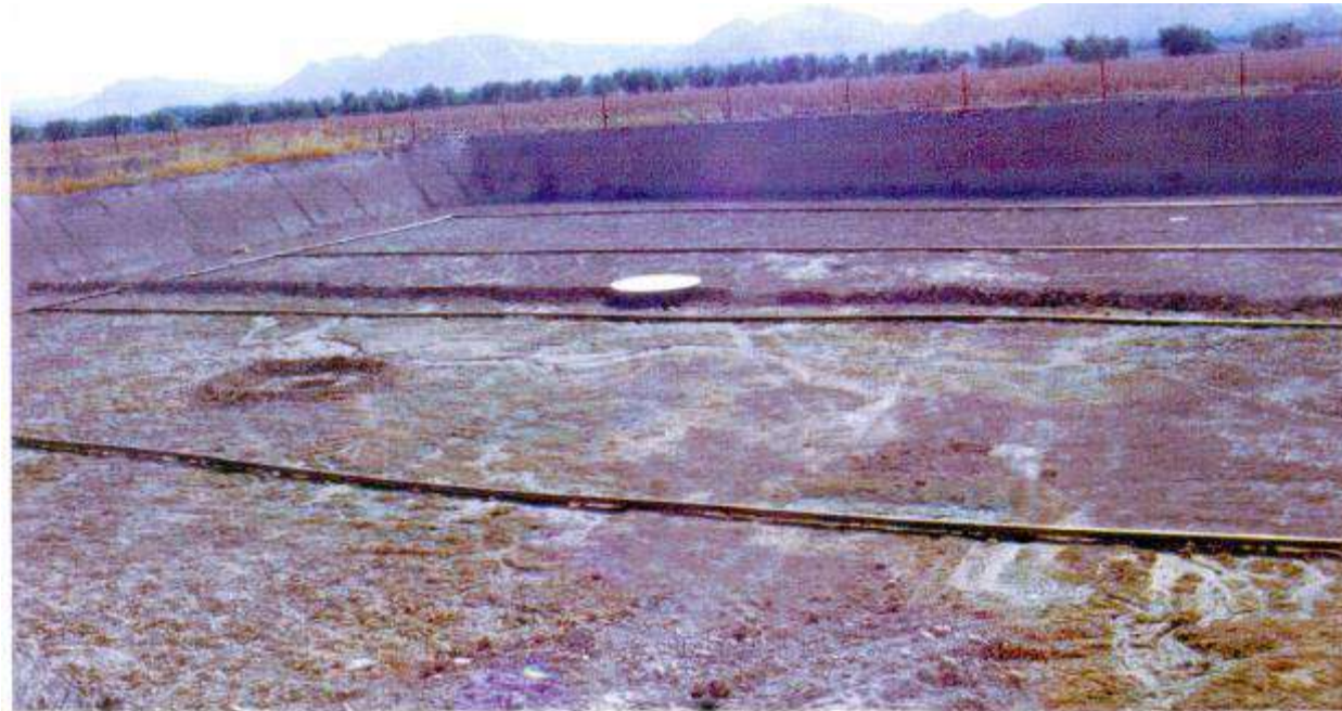
Foto 7.4 Vista general de una de las balsas de infiltración
