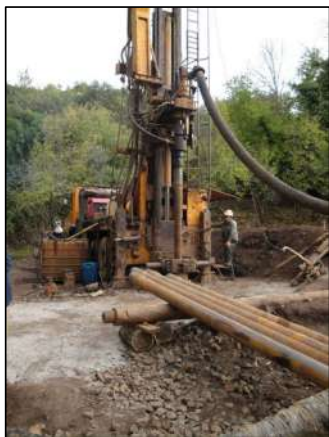
Fotos 5. Máquina de perforación a circulación inversa que alcanza mayores profundidades y extracción de caudales con bomba sumergible (Fuente. Izquierda: colección personal y derecha: Esther Sánchez Sánchez)
