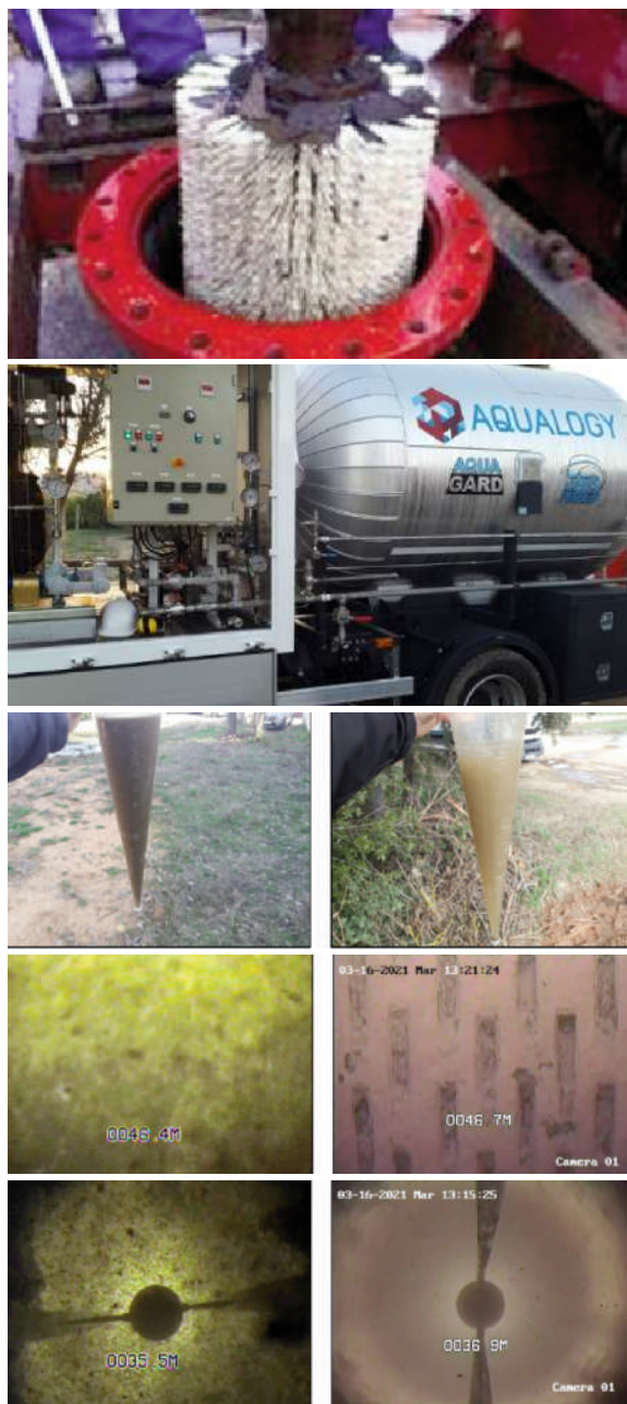
Figura 2. Operaciones de limpieza y desarrollo de sondeos con CO 2 líquido
