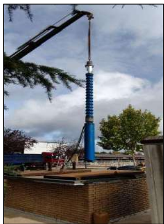
Fotos 5. Máquina de perforación a circulación inversa que alcanza mayores profundidades y extracción de caudales con bomba sumergible (Fuente. Izquierda: colección personal y derecha: Esther Sánchez Sánchez)
